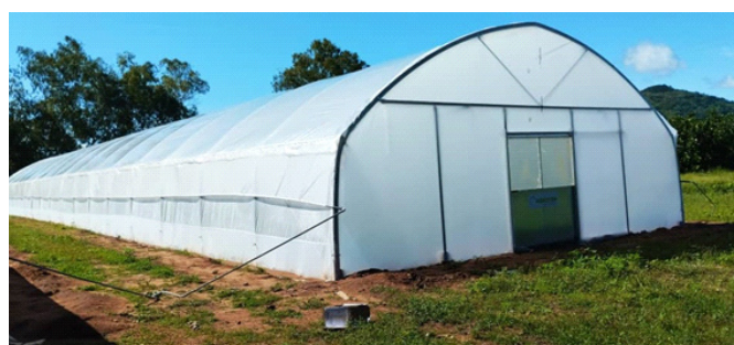
Figure 1. Ombrière moderne recouverte de toile moustiquaire
