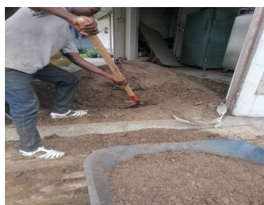
Figure 6: Mesure de la terre avec une brouette
