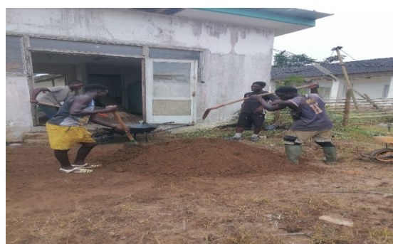
Figure 8: Séance de mélange homogène de terre simple avec le résidu de grains de café
